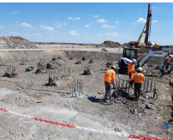
Recépage par l'entreprise Charier des 32 pieux de la future dalle béton armé siège des futurs mâts d'éoliennes à pré-assembler.
