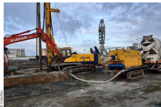
Réalisation inclusions rigides de type Inser par l'entreprise Keller.
