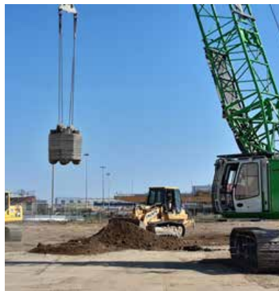
Compactage dynamique réalisé par l'entreprise Menard au droit de la future zone de stockage des nacelles.
