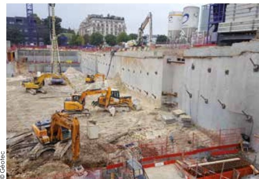
Paroi moulée côté allée Suzanne-Lenglen (phase 3).
