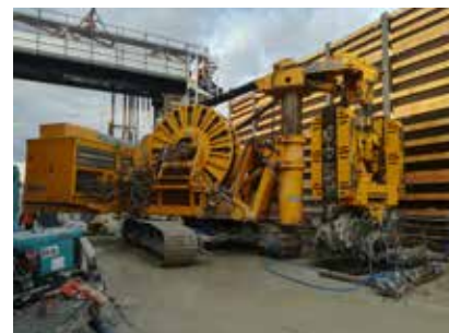
Foration à la fraise hydraulique d'une barrette de P2.
